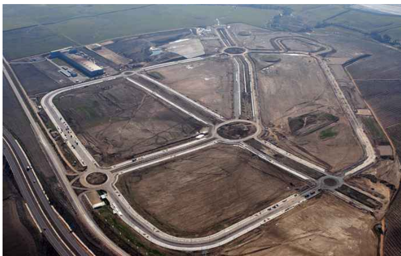
Foto aérea del Parque Industrial y de Servicios El Esparragal
